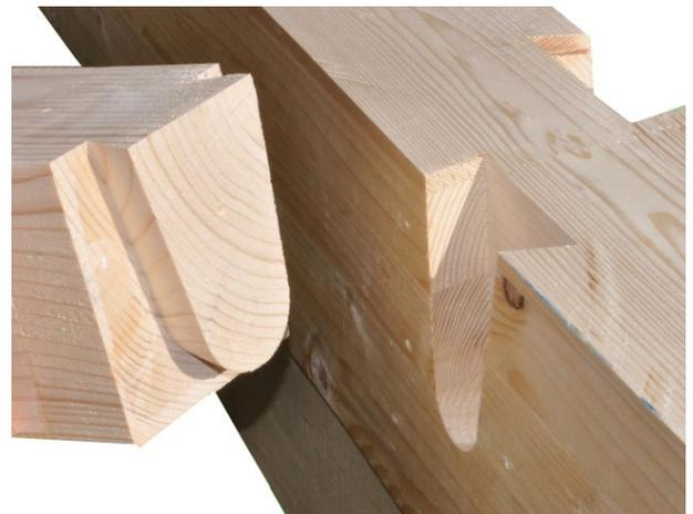
Bild 1. Schwalbenschwanzverbindung
