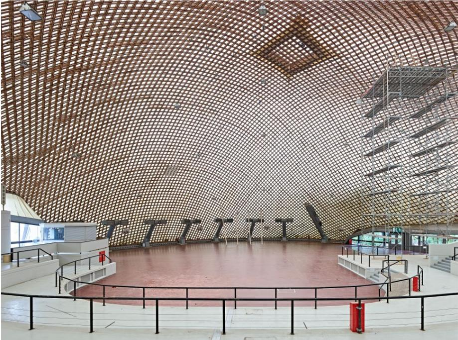
Bild 4. Innenraum der Veranstaltungshalle mit Tribünen und Gitterschale
