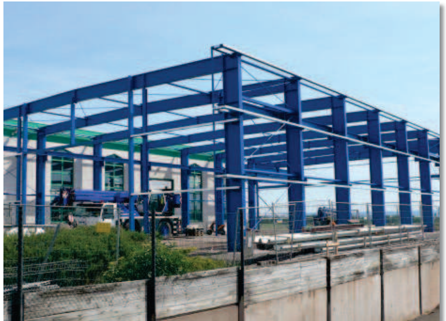
Hallentragwerk (Zweigelenrahmen) aus Stahl.
